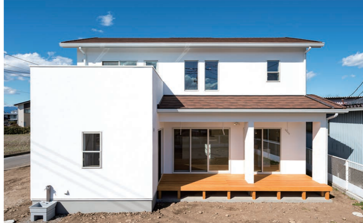
施主が特にこだわった漆喰の塗り壁。かつての城や蔵に代表されるように、その性能や質感をより活かすなら、選択肢は「白」以外にない。洗濯物を干した際、急な天候の変化にも慌てることがないよう深い軒に守られたウッドデッキも特長で、夏の直射日光を遮る役割も担っている。(この見開き写真は一部を除きM氏邸)
