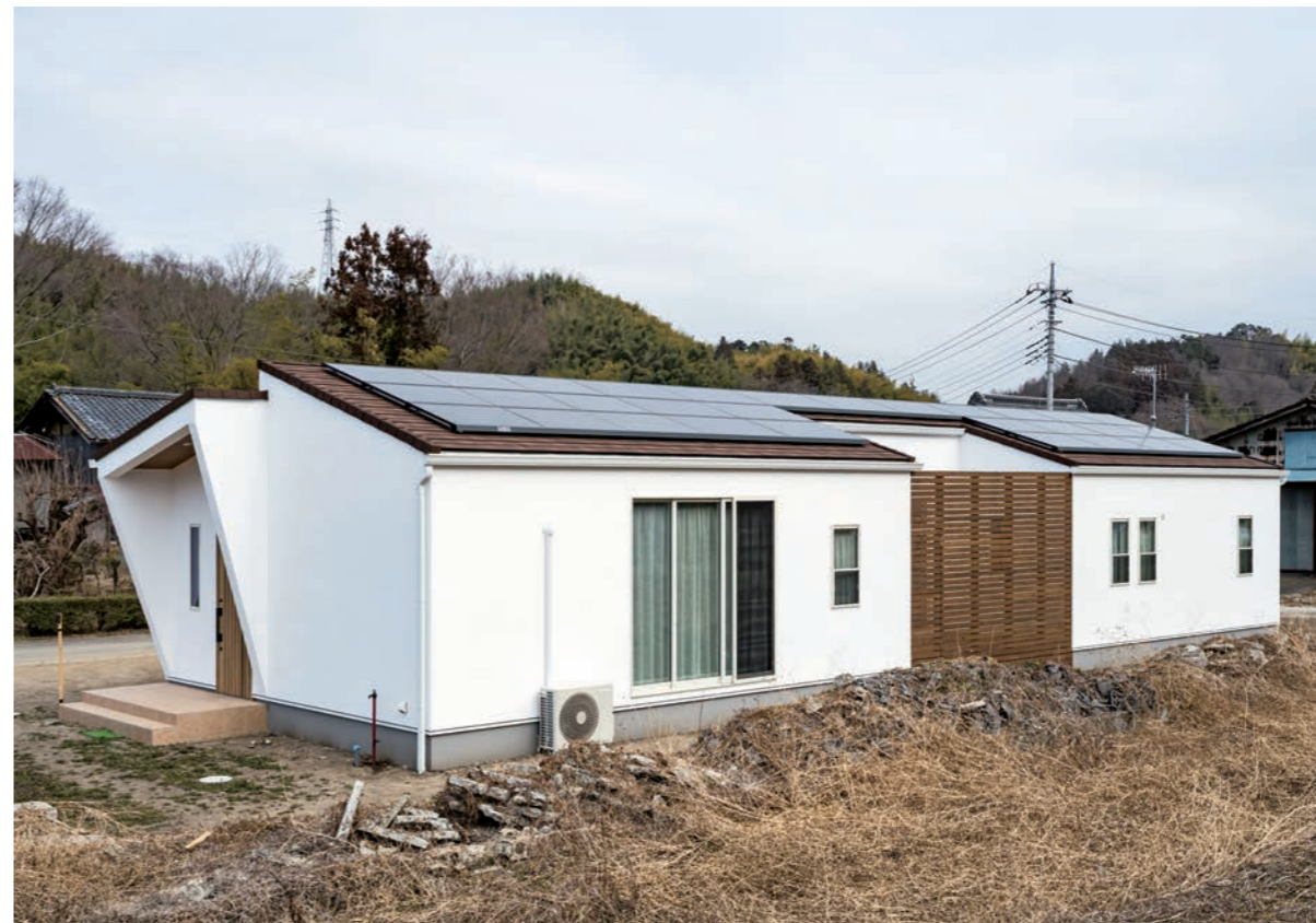
200坪という広大な敷地に実現した平屋の住まい。どの空間も満遍なく隔の光が差し込むよう長方形でプランニングしており、延床面積34坪とは思えないほどのボリュームを感じさせてくれる。また、屋根にはLIXILの「建て得バリュー」を活用して、10kWもの太陽光パネルを搭載。(この見開き頁の写真は一部を除きU氏邸)
